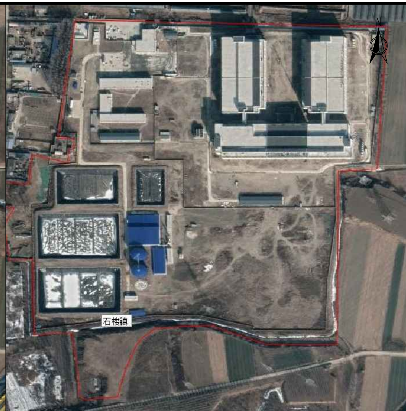
建设前遥感影像图（2022年1月）
